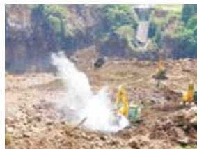
遠隔操作により無人で稼働する建設機器
